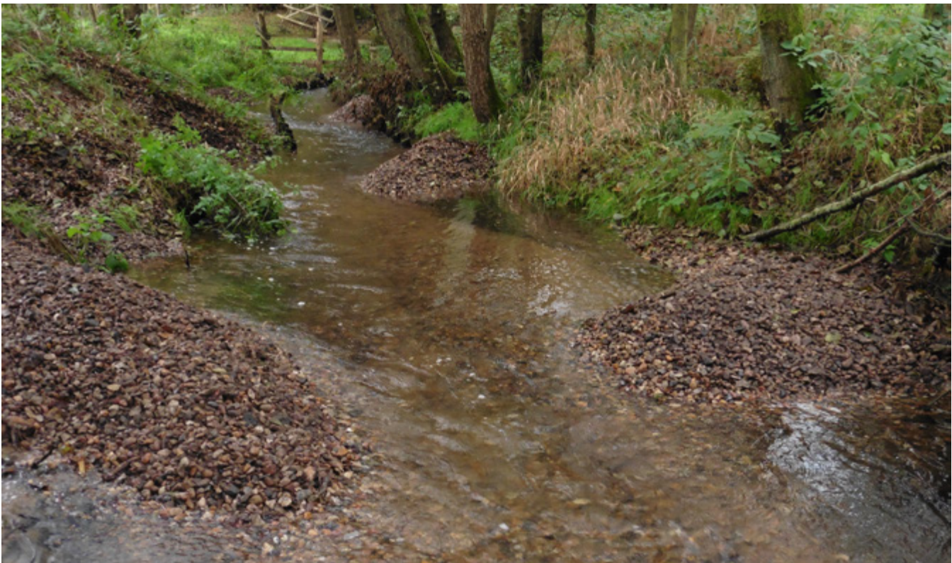
Abb. 4.8: Einbringen von Kies in den Mühlenbach zur Erhöhung der Rauigkeit des Gewässerbettes (W. Mielke)
