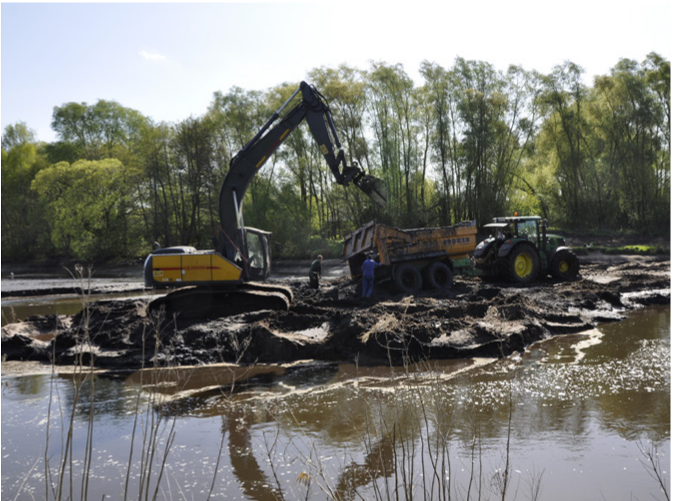
Abb. 2.10: Ausbaggerung des Mühlenteichs in Buxtehude im Jahr 2015 (TUHH)
